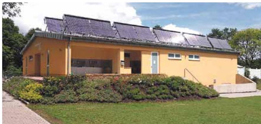
Sanitärgebäude am Bostalsee mit Solarthermie-Anlage zur Warmwasserbereitung
